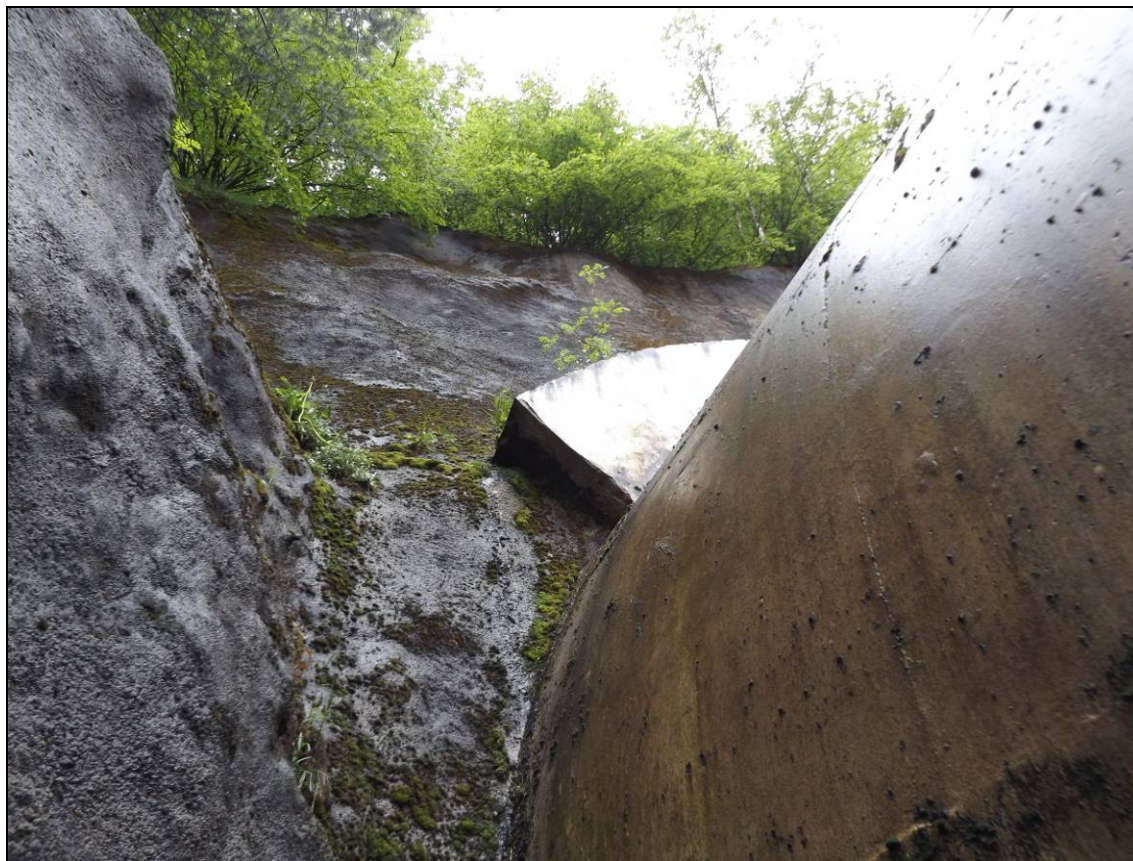
Obr. č. 20 – pohled na levou stranu výjezdového portálu – zachovalá cementová omítka vnějšího líce a stříkaný beton na skalním svahu porostlý mechem a drobnou vegetací
