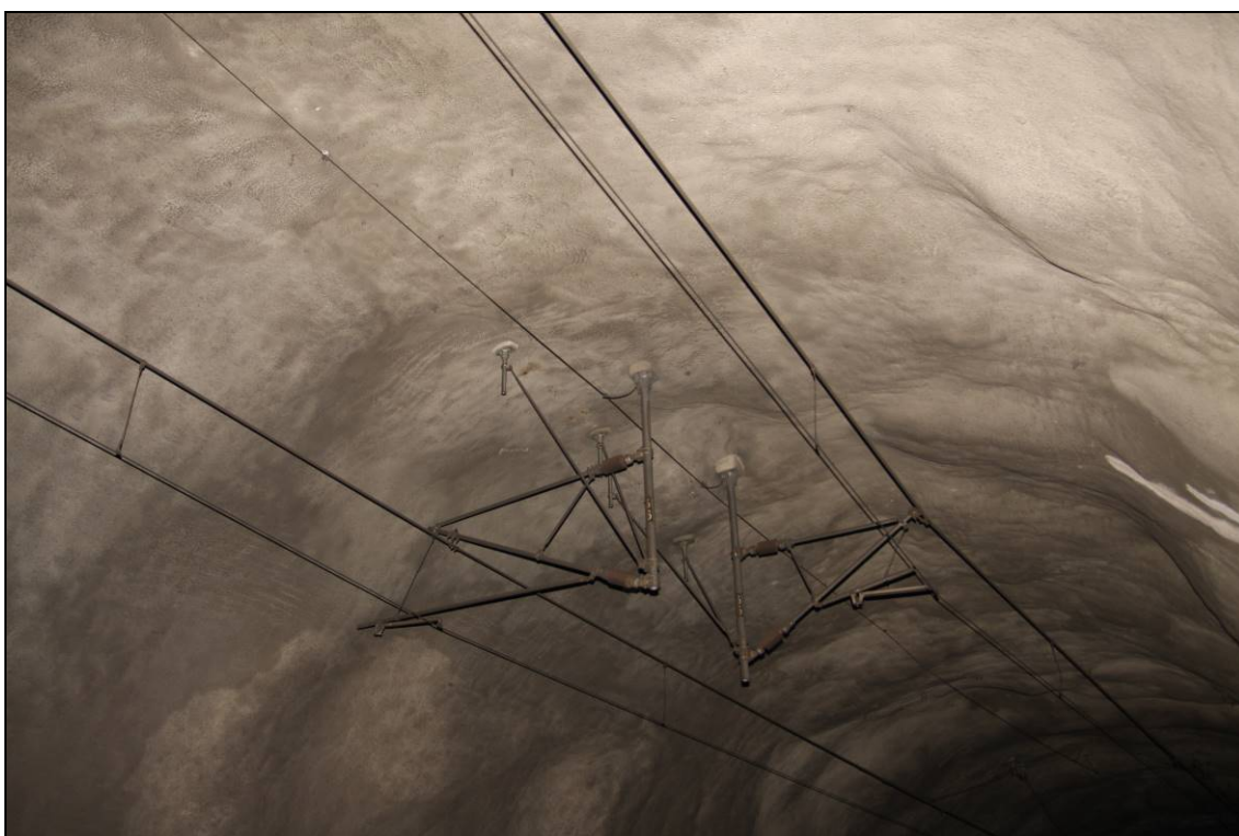
Obr. č. 15 – pohled na klenbu tunelového pásu č. 11, trakční konzola č. 65 a 66 - bez průsaků, vpravo stopy po diagnostických vrtech 2/1/11/2 a 2/1/11/3
