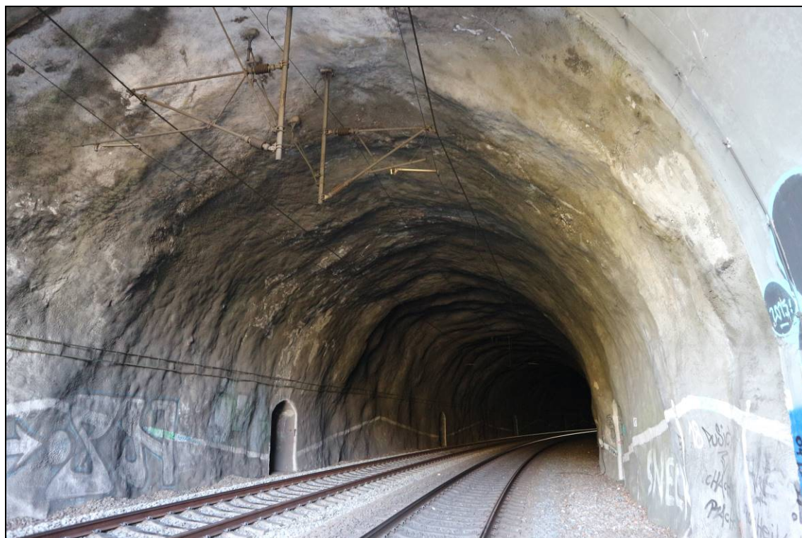
Obr. č. 17 – pohled na vnitřní líc ostění tunelového pásu č. 16-19 - dlouhodobé plošné a bodové průsaky skrze klenbu ostění
