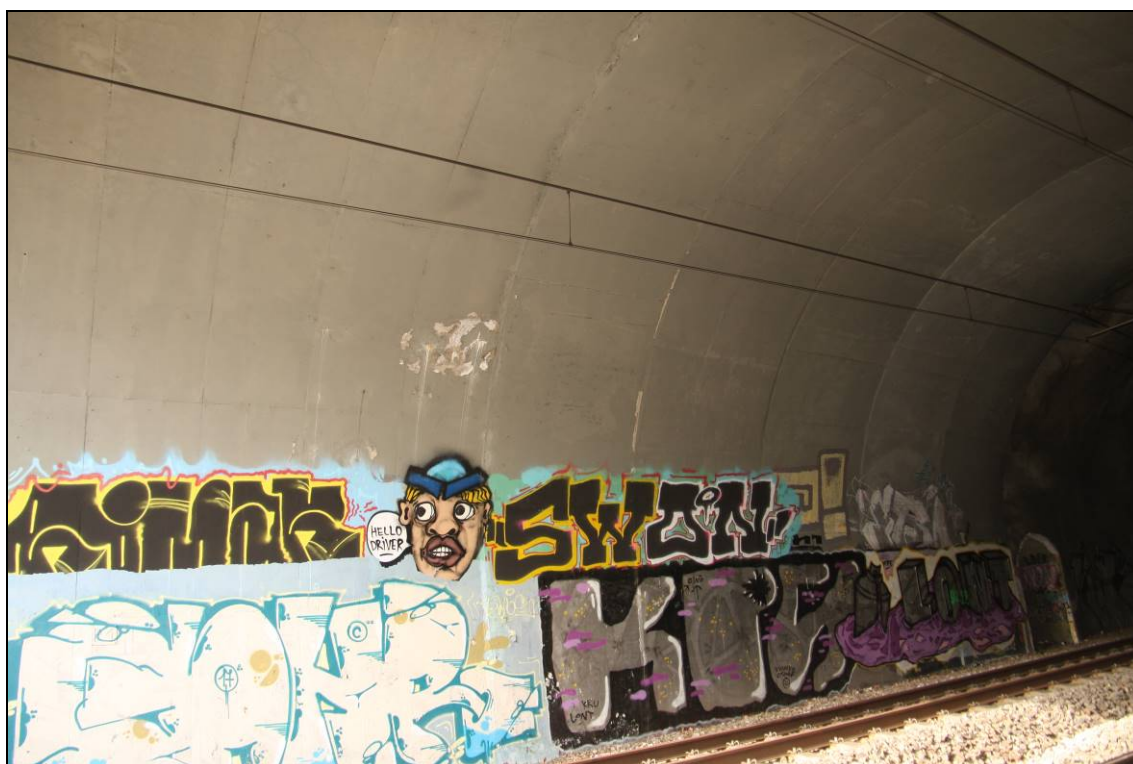
Obr. č. 13 – pohled na vnitřní líc ostění tunelového pasu č. 2-4, vlevo nad kolejí č. 1 - lokální slabé plošné průsaky skrze poruchu v ostění
