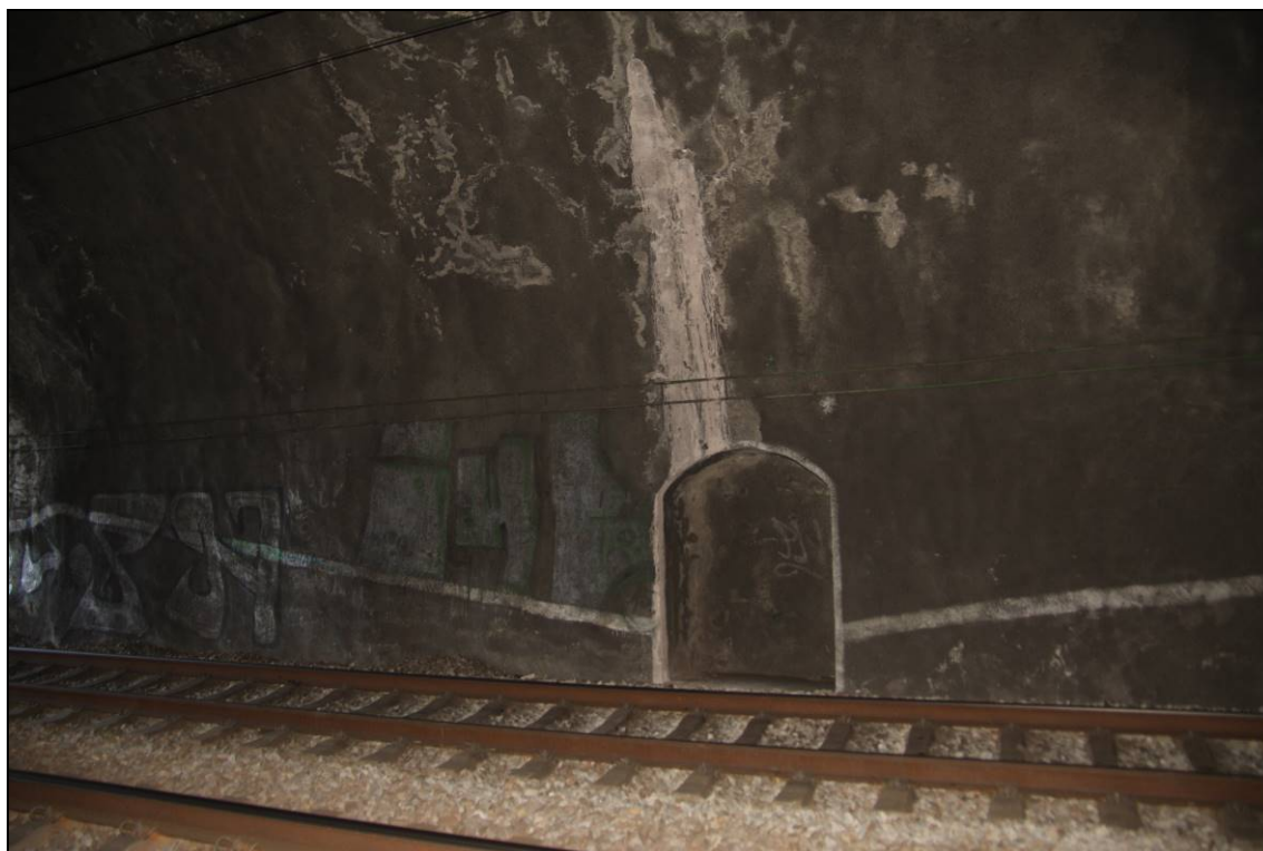
Obr. č. 16 – plošné průsaky skrze trhliny v ostění vpravo nad výklenkem v tunelovém pásu č. 16
