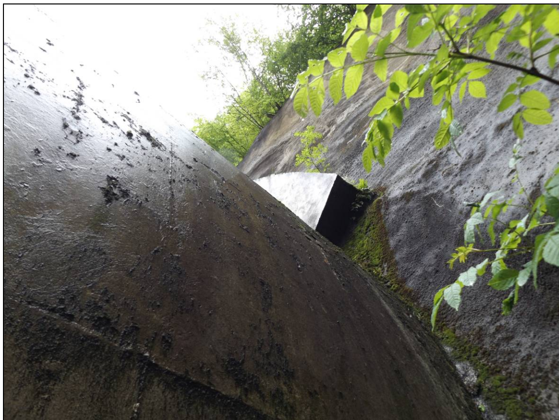
Obr. č. 21 – pohled na pravou stranu výjezdového portálu – zachovalá cementová omítka vnějšího líce
