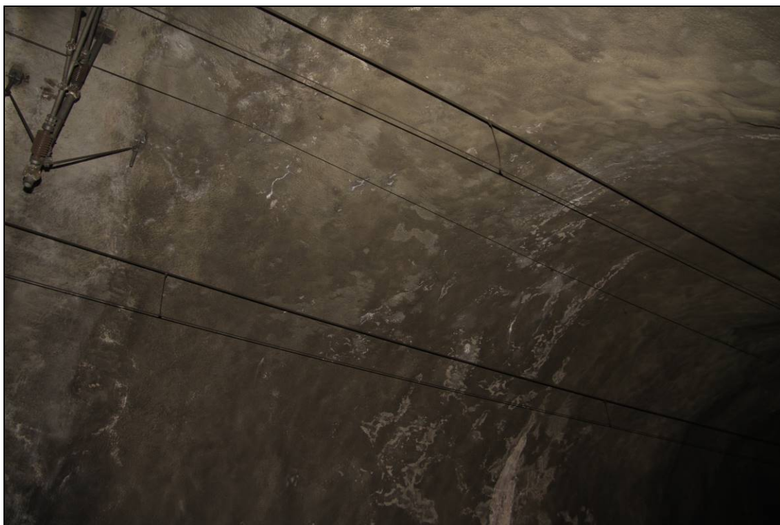
Obr. č. 18 – detail plošných a bodových průsaku skrze klenbu tunelového pásu č. 16 a 17 vpravo nad kolejí č. 2
