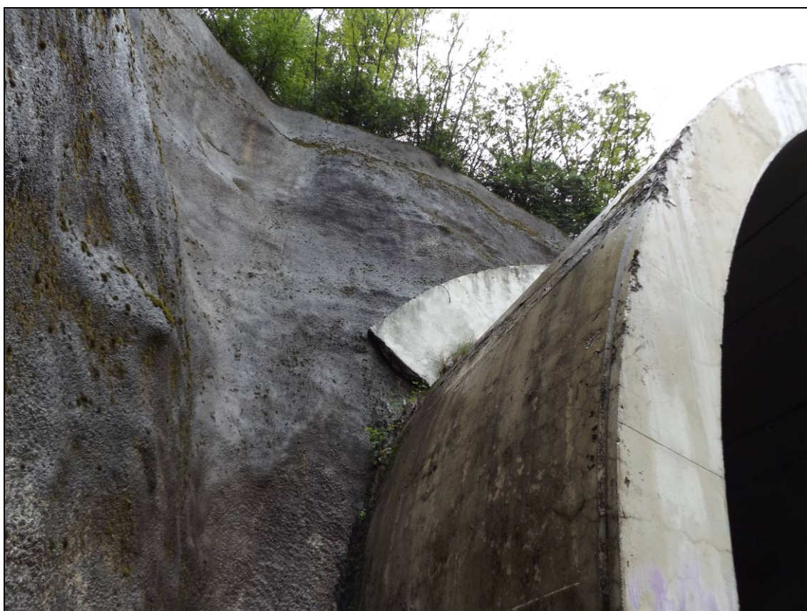
Obr. č. 11 – pohled na levou stranu vjezdového portálu – vnější líc ostění krytý cementovou omítkou (zachovalá) a v horní části viditelný betonový límec mezi portálem a skalním svahem
