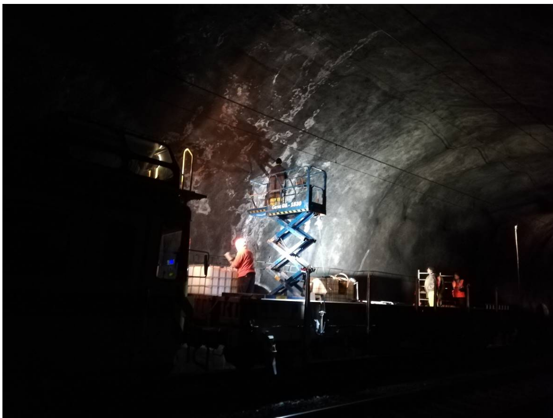
Obr. č. 23 – provádění diagnostických vrtů - tunelový pás 16, vpravo nad kolejí č. 2
