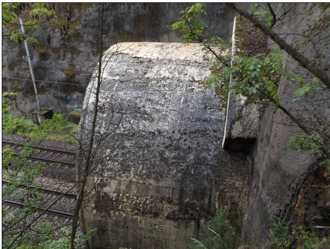
Obr. č. 12 – pohled na pravou stranu vjezdového portálu a vnější líc ostění porušený opady
